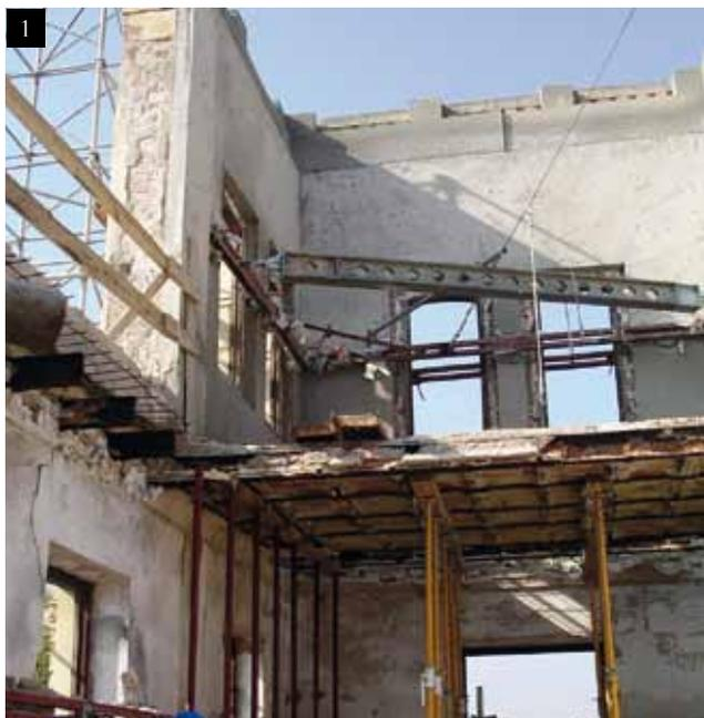
1 Consolidación de muros de fachada, simultaneando la operación con los desmontajes de la estructura arruinada.
