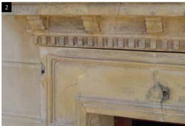
2 Elemento ornamental de hormigón prefabricado que conserva parte de la pintura de color ocre, realizada a la cal, que ha ido desapareciendo con el tiempo por el lavado del agua de lluvia.
