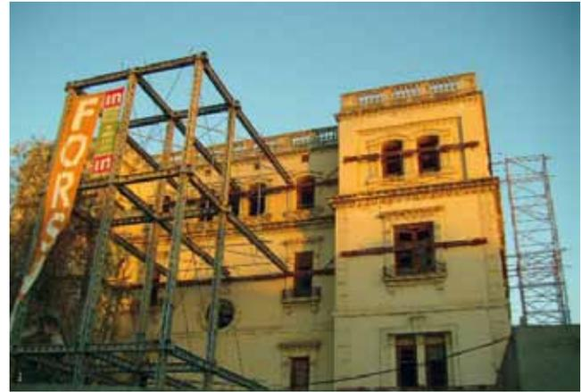
2 Acodalamientos para la estabilización de los muros de fachada.
