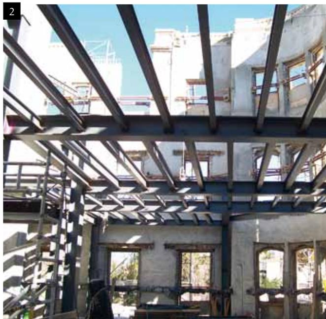
2 Montaje de la nueva estructura de acero.
